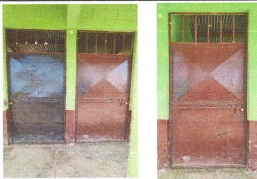
Foto 3: Se observa el deterioro de las puertas de metal.
