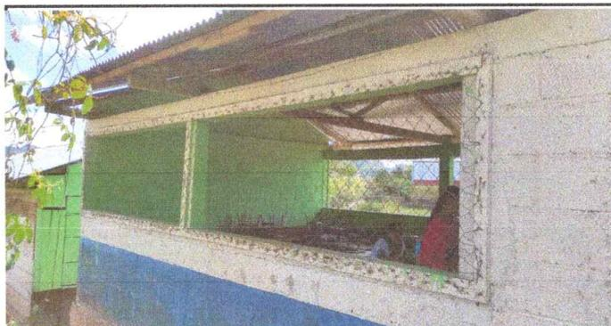
Foto 6: Se observa el deterioro de la malla y por consecuencia el aula está insegura y/o vulnerable.
